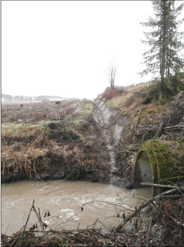
Valtatie 12 tiepengerryksen ja savisen pellon väliin kaivettu pelto-oja sekä tien alittavan ojan betoninen ojarumpu.
