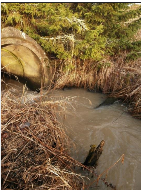
Valtatie 12 alittavan ojan kaak- koispuolisen ojarummun edustan lahonneita puunjännöksiä.
