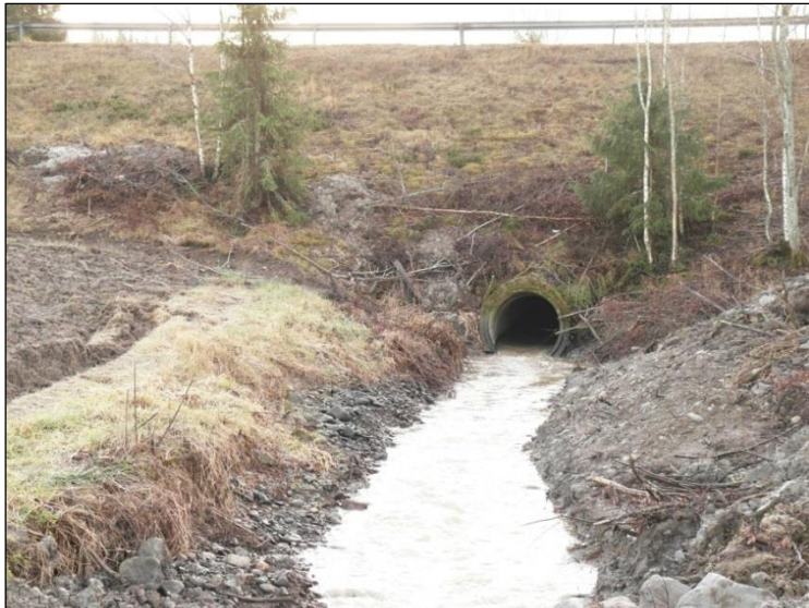
Valtatie 12 alittava oja, tien luoteispuolella. Ojaan kaivettu hiljattain, ojan reunoilla suuret maakasat. Kuvattu kaakkoon.
