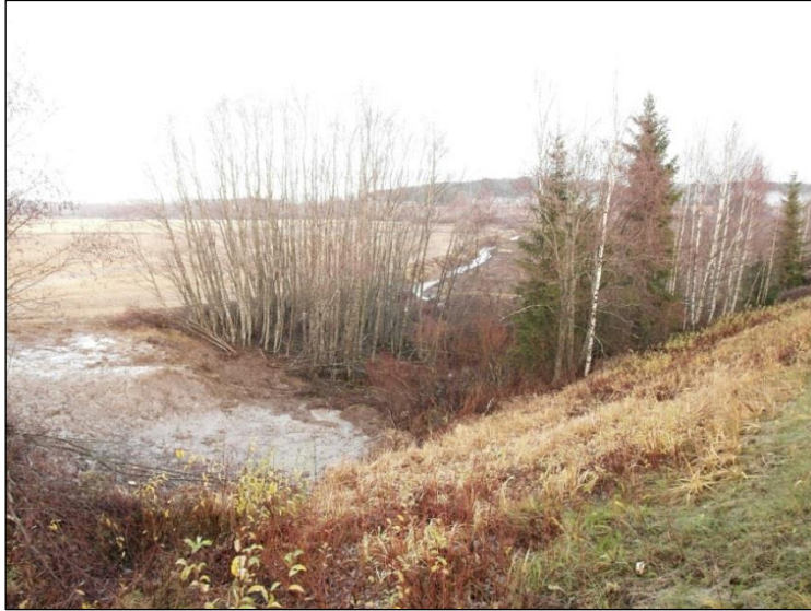
Kaivettua maastoa valtatie luoteispuolella. Tien alittavan ojan lounaispuolella.
